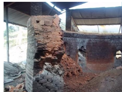
Figura No 2: Desmonte horno Colmena
