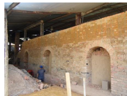
Figura No 3: Construcción horno cámaras.
