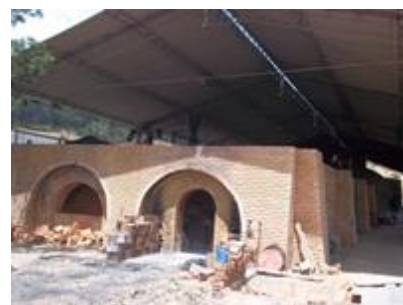
Figura No 4: Construcción horno ZIG ZAG
