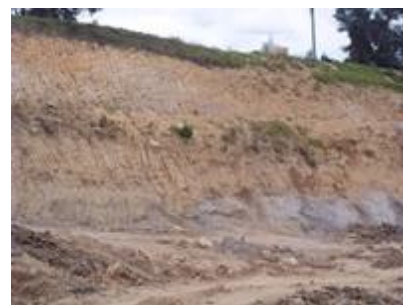
Figura No 2: Frentes de excavación
